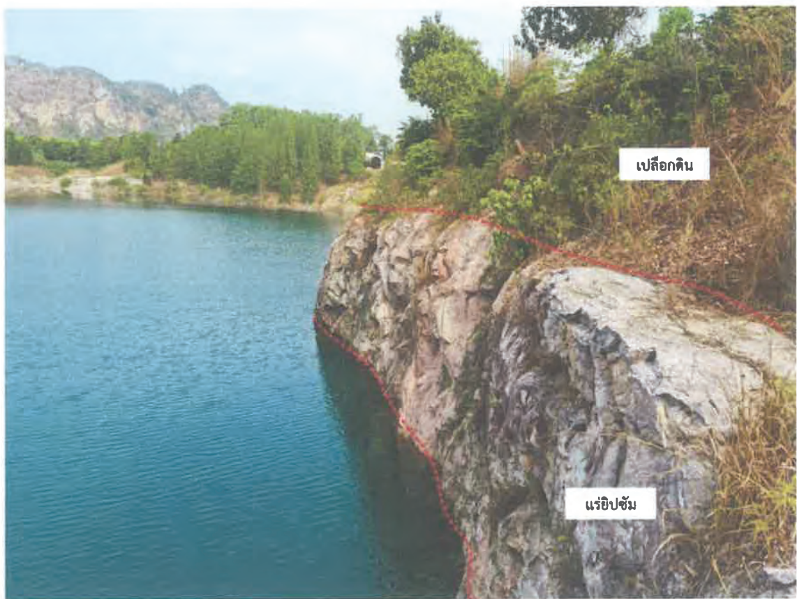
รูปที่ 3 การวางตัวของชั้นแร่ดิบซั่มและเปลือกดินของผนังบ่อเหมืองในปัจจุบัน (มองไปทางทิศตะวันตกเฉียงเหนือ)
